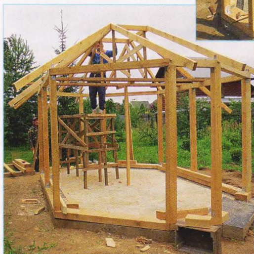
Монтаж стропильной системы.
