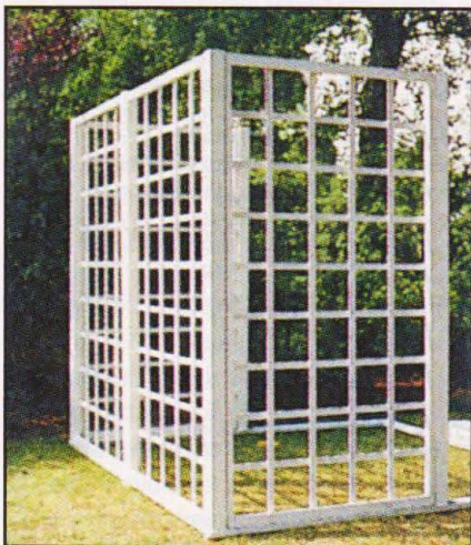
После установки ещё двух решётчатых элементов конструкция приобретает определённую устойчивость.
