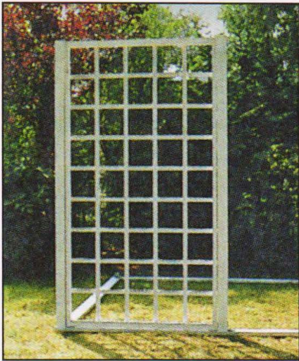
Установку первой решётчатой рамы между опорами начинают с одного из углов нижней обвязки.
