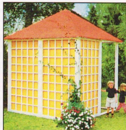
В ненастную погоду от дождя защищает тент, натянутый на каркас крыши. Тент крепят к рамам кнопками.
